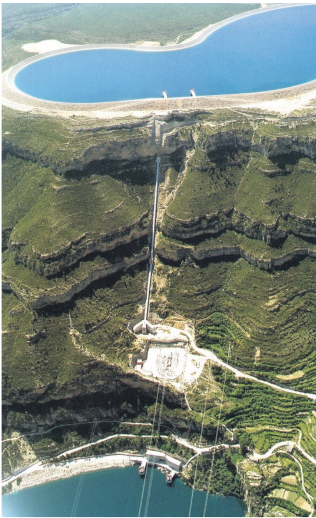
Central hidroeléctrica de bombeo de Cortes-La Muela, en la provincia de Valencia.
